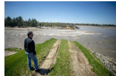
2020.05.19 Dam burst Michigan, USA
