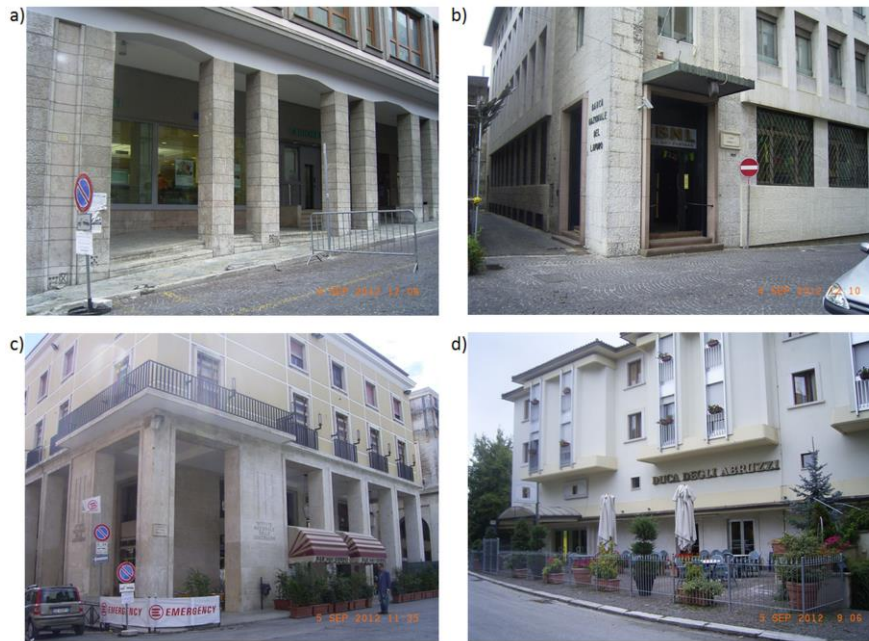
Figure 5. a) Savings Bank of Chieti – Carichieti – Agency of L'Aquila in 2012, three years after the earthquake (Cassa Di Risparmio Della Provincia Di Chieti - Carichieti - Agenzia Di L'Aquila); b) National bank of business in 2012 (Banca Nazionale del Lavoro); c) National Institute of the insurance in 2012 (Istituto Nazionale delle Assicurazioni), and d) Hotel Duca Degli Abruzzi in 2012 (Photos: Diana Contreras).
