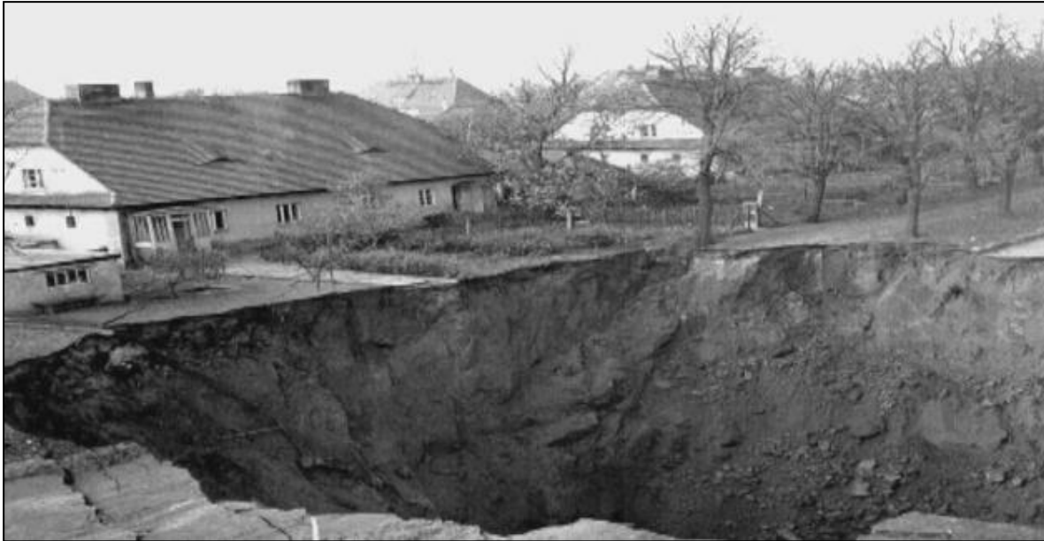
Figure 1. Sinkhole caused by salt cavern collapse, Wapno salt mine, Poland https://tvn24.pl/poznan/wapno-wciaz-osuwa-sie-ziemia-przygotuja-plan-jak-ratowac-miejscowosc-5405290 , 21.05.2022)
